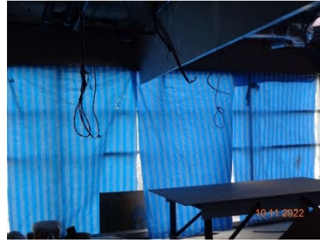
ภาพที่ 2.2-10 ผ้าใบกันฝุ่นภายในพื้นที่ก่อสร้าง
